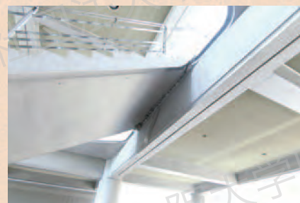
2018年6月 接続部分が折れた医学部共通棟の中央階段
